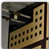
Přizpůsobení rozvodům ve sklepi
