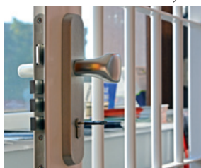
Otvíravá mříž s integrovaným rozvorovým zámkem
