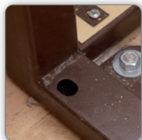
Protikus spodního uzamykání
